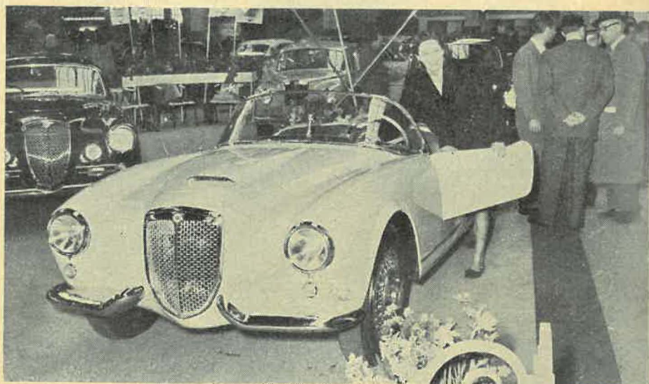
Og her er så vor yndlingsvogn over alle vogne: Lancia Aurelia Gran Turismo 2500 Spyder med Farina karosseri. Seks-cylindret V-motor (60°), boring 78 mm, slaglængde 85,5 mm, slagvolumen 2451 ccm, kompressionsforhold 8:1, effekt 118 hk ved 5000 omdr. min. Dobbelt Weber karburator. Gearkasse sammenbygget med differentiallet på bagakslen. Maksimal hastighed ca. 185 km/t. Benzinforbrug ca. 12,7 liter pr. 100 km.
