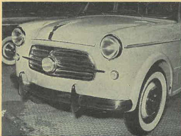
I kølgitteret på Fiat 1100 TV er indbygget en lille kurvelygte, der er således monteret til styretøjet, at den følger forhjulenes bevægelse. Model 1100 TV er ivotrigt en ret fabelagtig vogn med en ganske overordenlig kraftig og levende motor.
