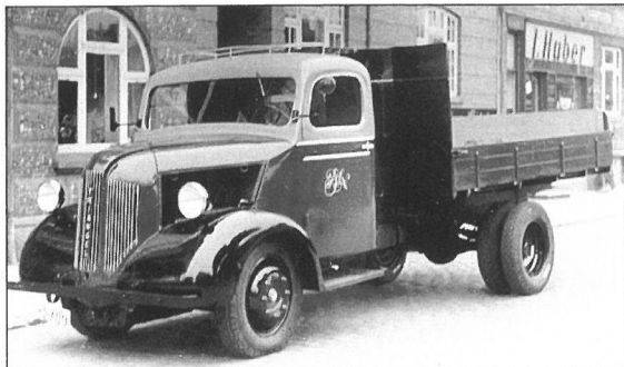
Triangel 1941 med lad der svarer til den kalkulerede størrelse. Generatoren blev monteret i højre eller venstre side, på lastbiler til langtransport af tømmer eller stålbjælker blev den placeret bag i ladet mellem chassisvangerne. Generator brændet opbevarede man i sække på førerhuset.
